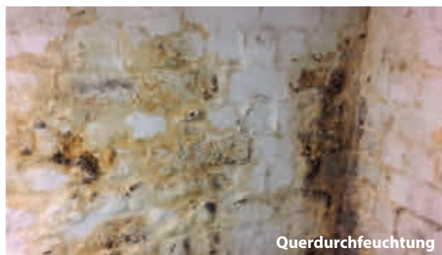
defekte Horizontalsperre
