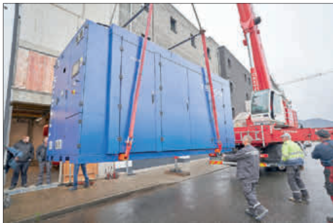
Mithilfe eines Krans wird das acht Tonnen schwere BHKW in das Technikgebäude der evm manövriert. (Foto: Sascha Ditscher/evm)
