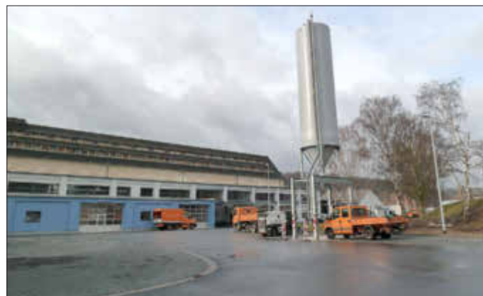
Der neue Baubetriebshof im Januar 2012
