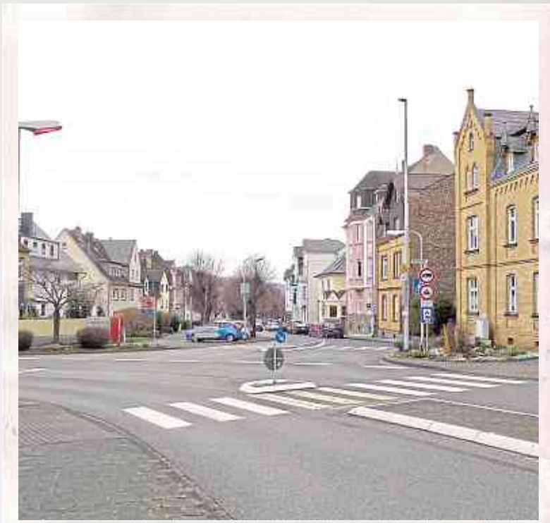
Auf private Initiative wurde an der Bergseite des Friedhofs später erneut eine kleine Kapelle aus aufbewahrten Trümmern der Ölbergkapelle errichtet. Die Kreuzung Burgstraße/Ostallee heute (rechts): Viele Lahnsteiner denken, man hätte die alte Kapelle stehen lassen und einen Kreisverkehr errichten sollen.
