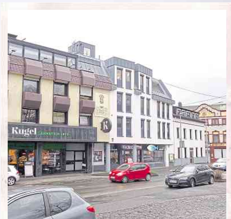
Kirchplatz und Brückenstraße 2018 (rechts): Die beiden linken Häuser wurden in den 1980er-Jahren neu gebaut und werden weiter gewerblich genutzt, während das Eckhaus zur Lahnstraße heute reines Wohnhaus ist. Bis heute gleich geblieben ist lediglich das Kopfsteinpflaster am Kirchplatz.
