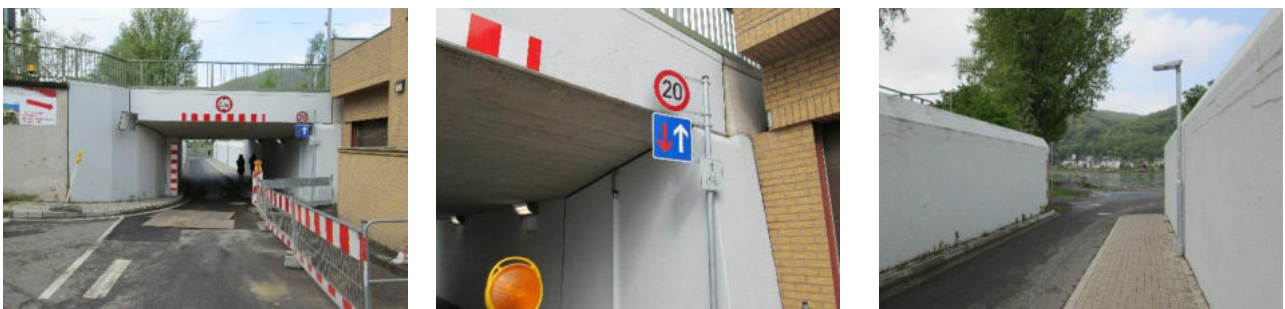
Abbildung 68: Unterführung an der Kirchstraße (Quelle: WSW & Partner)
