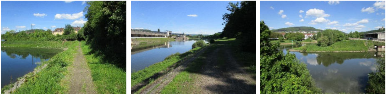
Abbildung 26: Hafendamm mit Hafenköpfchen (Quelle: WSW & Partner)
