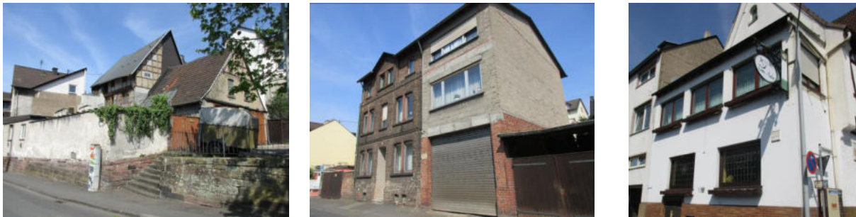
Abbildung 17: Gebäude mit Sanierungsbedarf in der Bürgermeister-Müller-Straße (Quelle: WSW & Partner)
