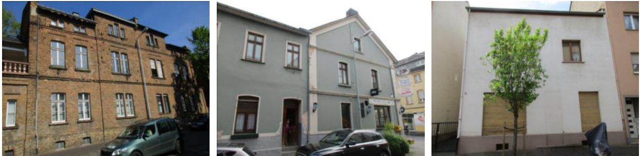
Abbildung 19: Gebäude mit Sanierungsbedarf in der Adolfstraße (Quelle: WSW & Partner)
