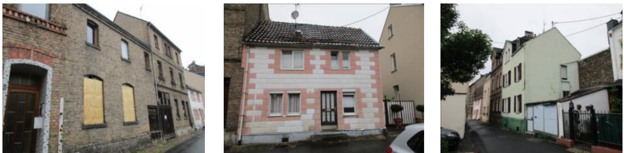
Abbildung 20: Gebäude mit (erheblichem) Sanierungsbedarf in der Weißergasse (Quelle: WSW & Partner)
