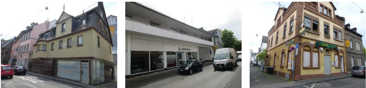
Abbildung 31: Gebäude mit Gestaltmängeln (Quelle: WSW & Partner)
