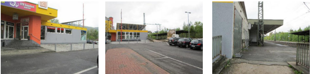
Abbildung 63: Bahnhof und Bahnsteig (Quelle: WSW & Partner)
