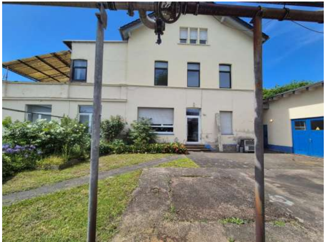
Abbildung 33 | Blick auf das Bürogebäude im Norden des Plangebiets; der Fundpunkt der Mauereidechse ist unten mittig
