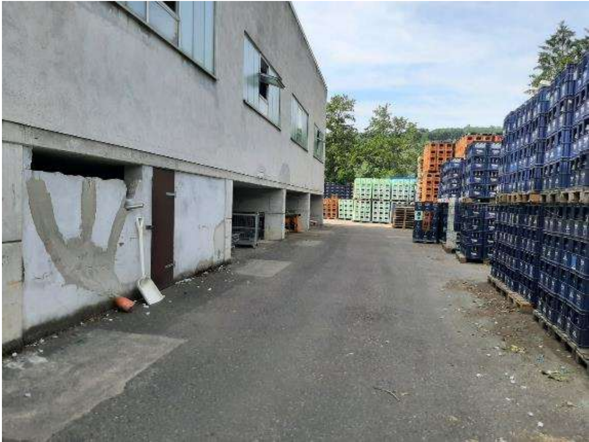
Abbildung 13 | Die mittlere Gewerbehalle, Blick Südwesten (Foto Planungsbüro Dittich)
