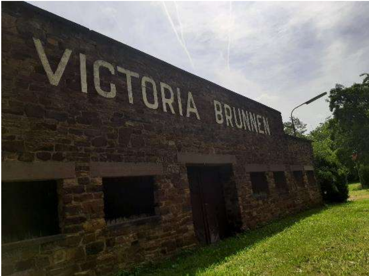
Abbildung 11 | Südwestl. Fassade der südlichen Gewerbehalle (Foto Planungsbüro Dittrich)
