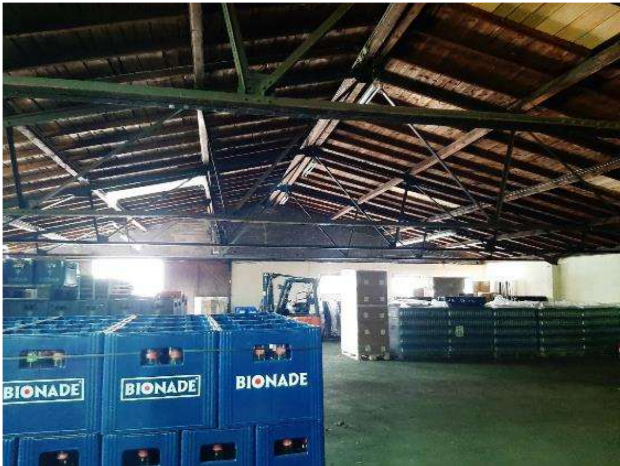
Abbildung 12 | Die südliche Gewerbehalle von innen (Foto Planungsbüro Dittrich)
