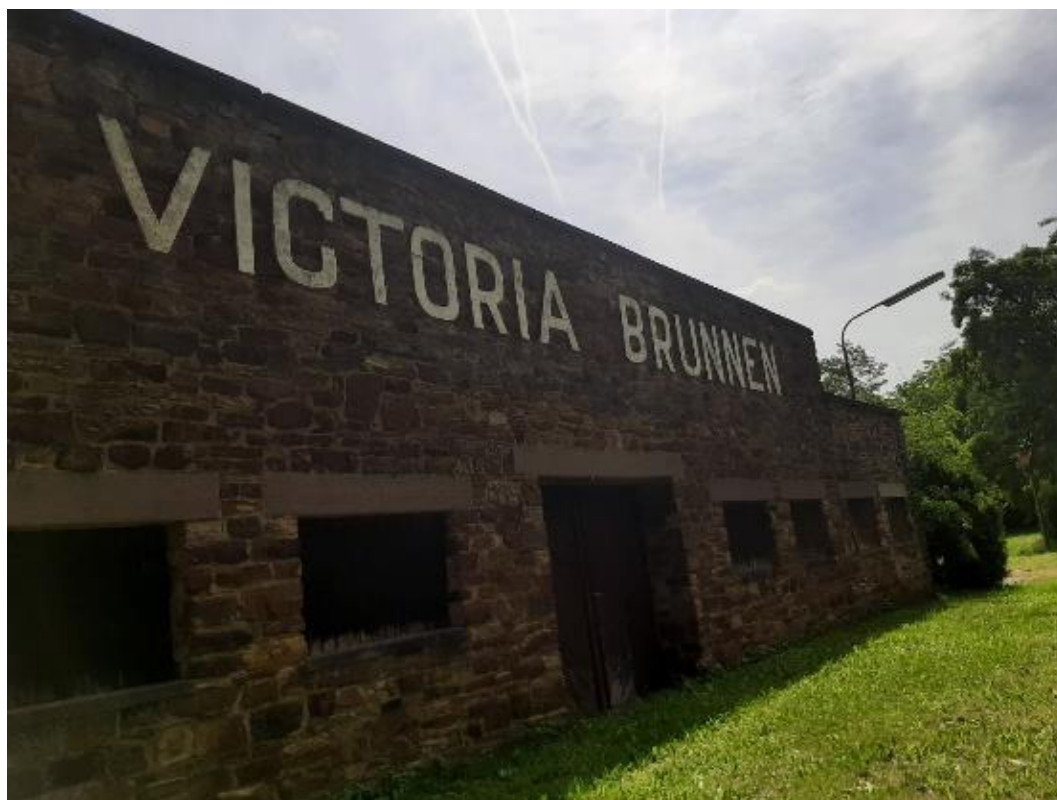
Abbildung 13 | Südwestl. Fassade der südlichen Gewerbehalle (Foto Planungsbüro Dittrich)
