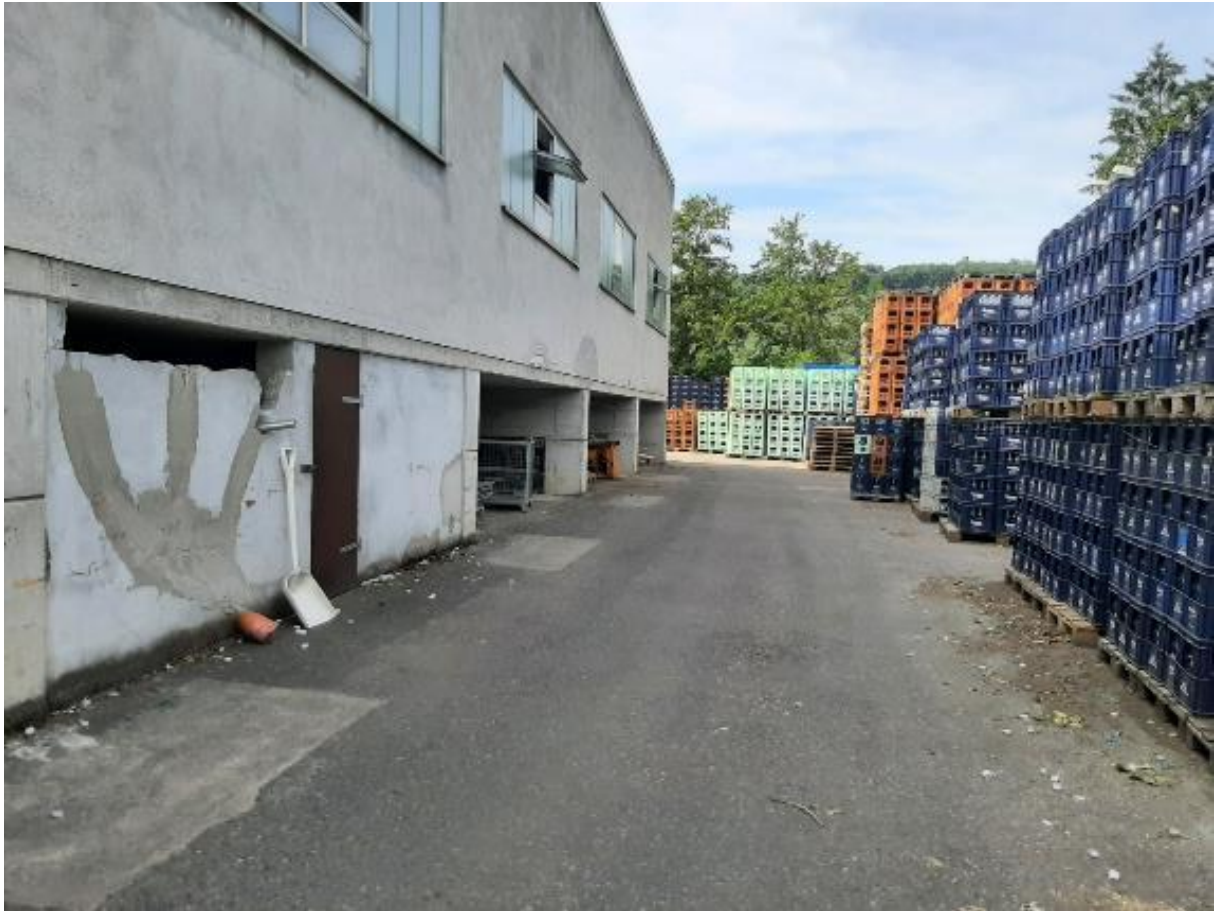
Abbildung 19 | Die mittlere Gewerbehalle, Blickrichtung Südwesten (Foto Planungsbüro Dittrich)
