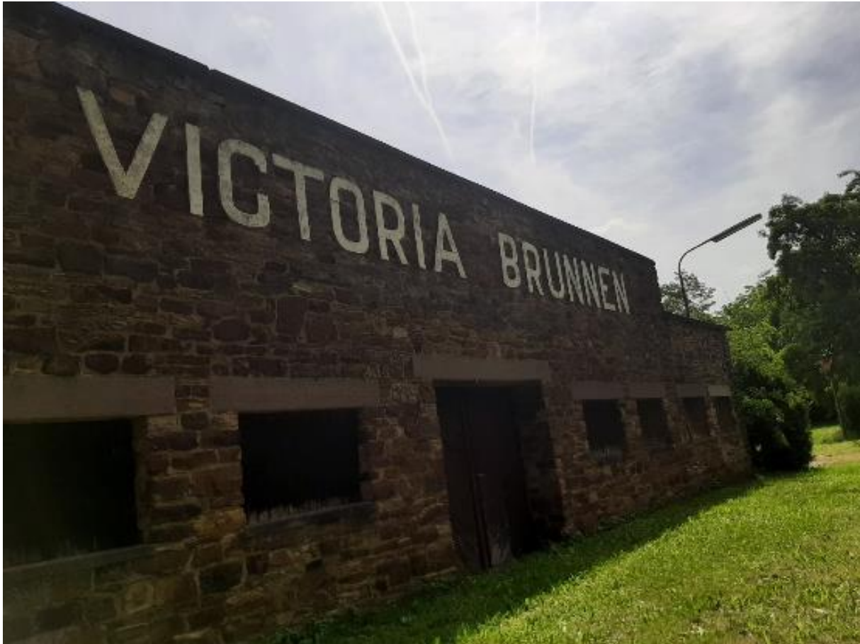
Abbildung 17 | Südwestl. Fassade der südlichen Gewerbehalle (Foto Planungsbüro Dittrich)
