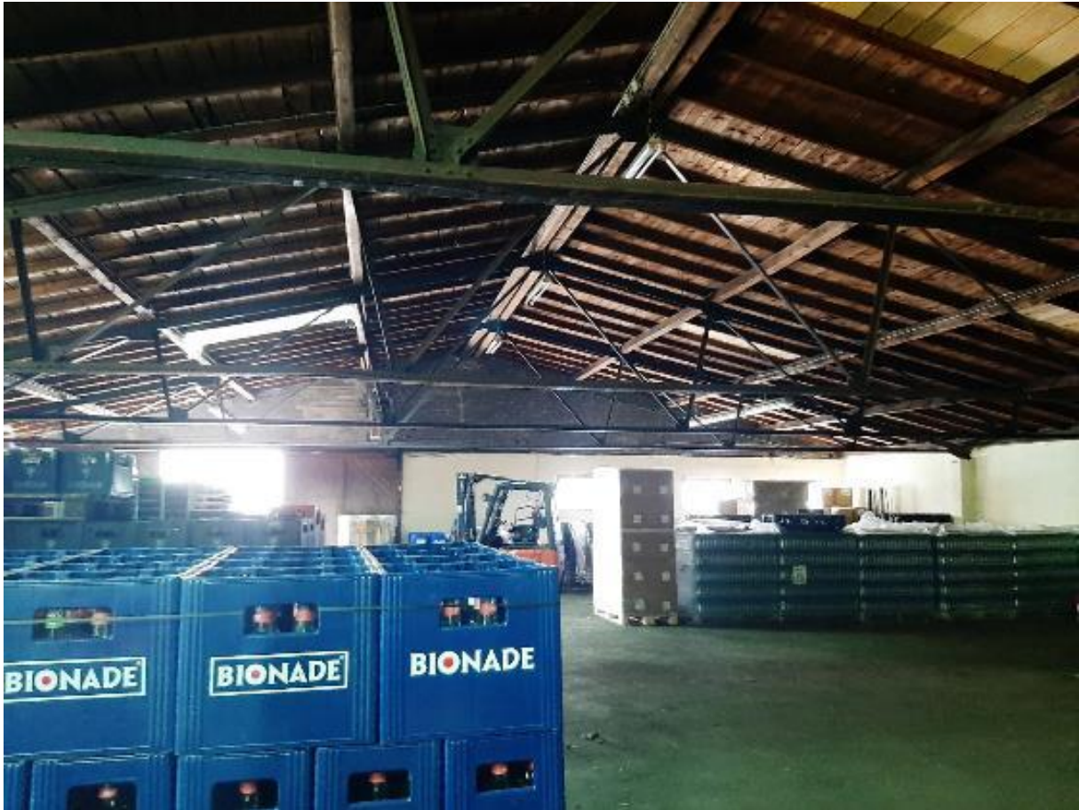
Abbildung 18 | Die südliche Gewerbehalle von innen (Foto Planungsbüro Dittrich)
