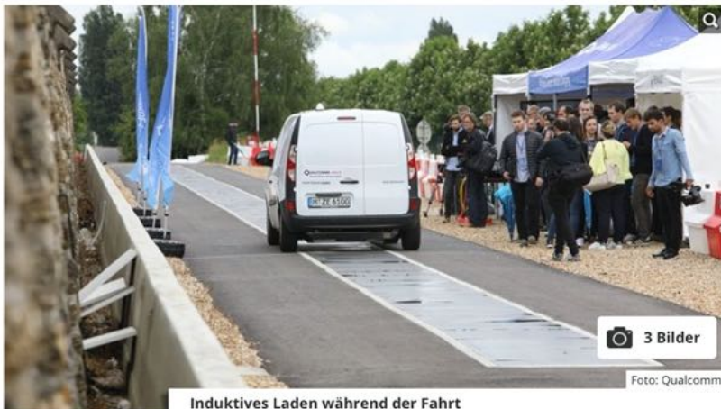
Induktives Laden während der Fahrt Schluss mit dem Kabelsalat
