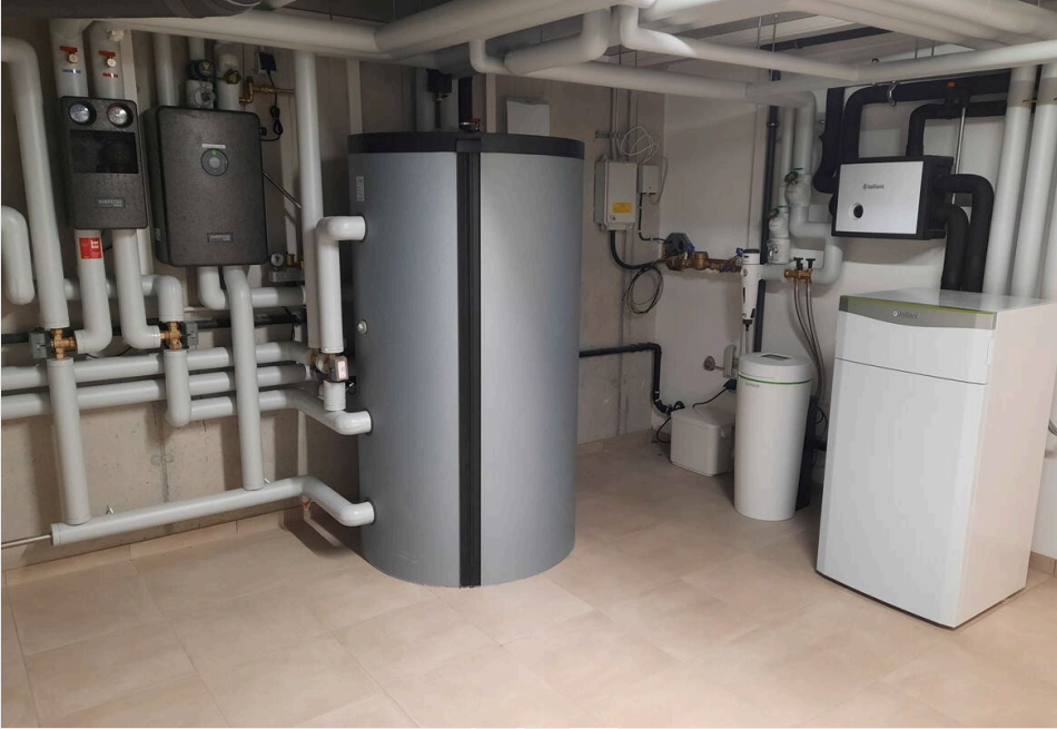
Einfamilienhaus Wärmepumpe mit Speicher und WW-Bereitung (Beispiel)
